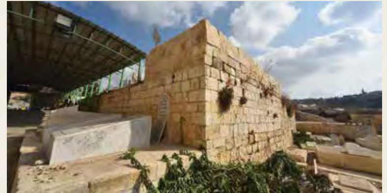
Mezarlığın başında Osmanlı Karakol Binası'nın kalıntıları
